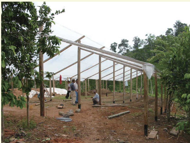
▲ Vivero a dos aguas con ventoleras. Valle del Patere, Esmeraldas.
